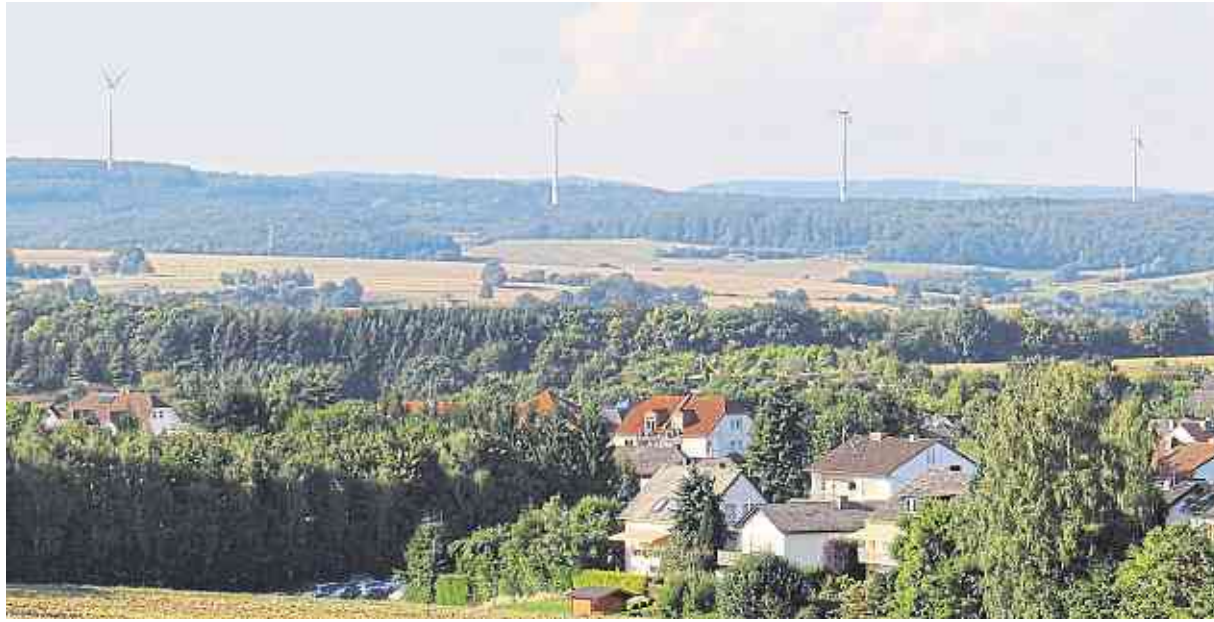
Beanstandet hatte der Ortsbürgermeister mangelnden Brandschutz durch die Nähe zum Waldgebiet. Foto: west
