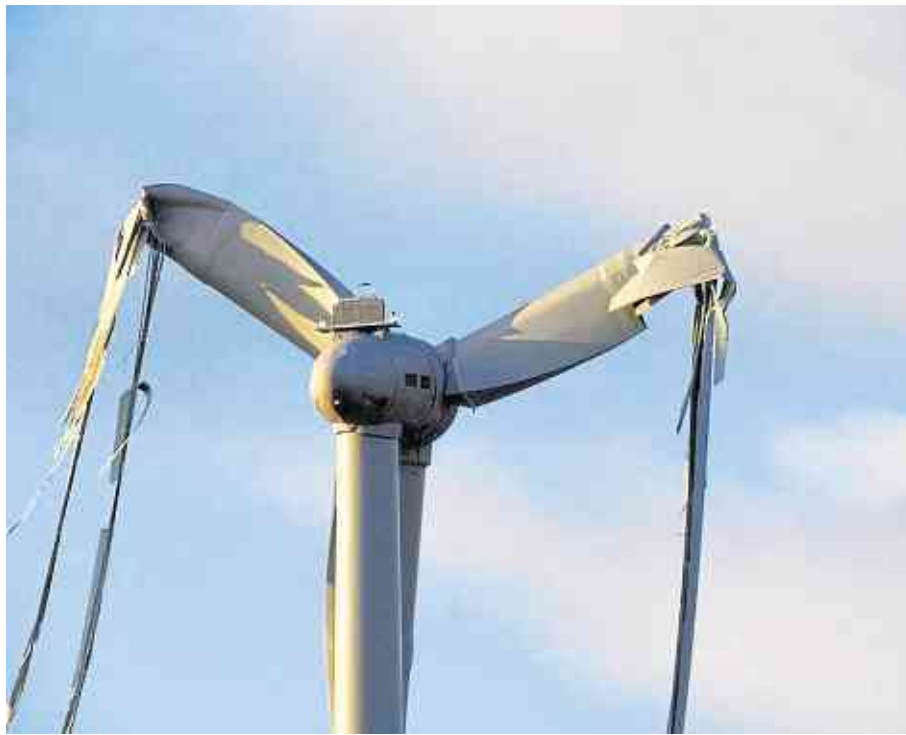
Beim Bau von Windrädern gelangen Schadstoffe ins Grundwasser.
