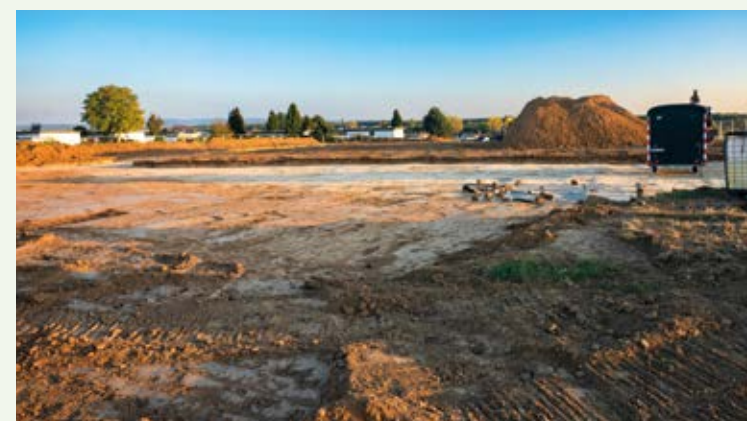
Neubaugebiet Mittelbuchen Nordwest-Vor dem Lützelberg - Fotos: Archiv NI
